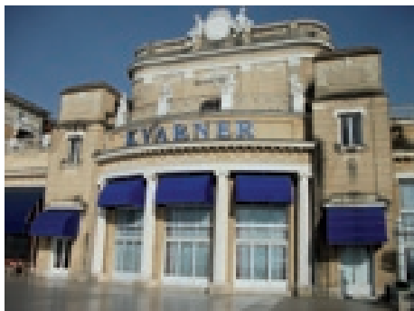
Hotel Kvarner, pogled z morske strani (foto: I. Pirč)
