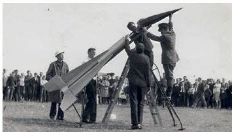
Nameščanje glave (konice) s pismi na raketo. Sodeluje major JLA, ki je pomagala s prevozi in raketašem dobavila električne vžigalne naprave, ki sicer niso bile v prosti prodaji. Fotografija iz arhiva A. Kersteina.
